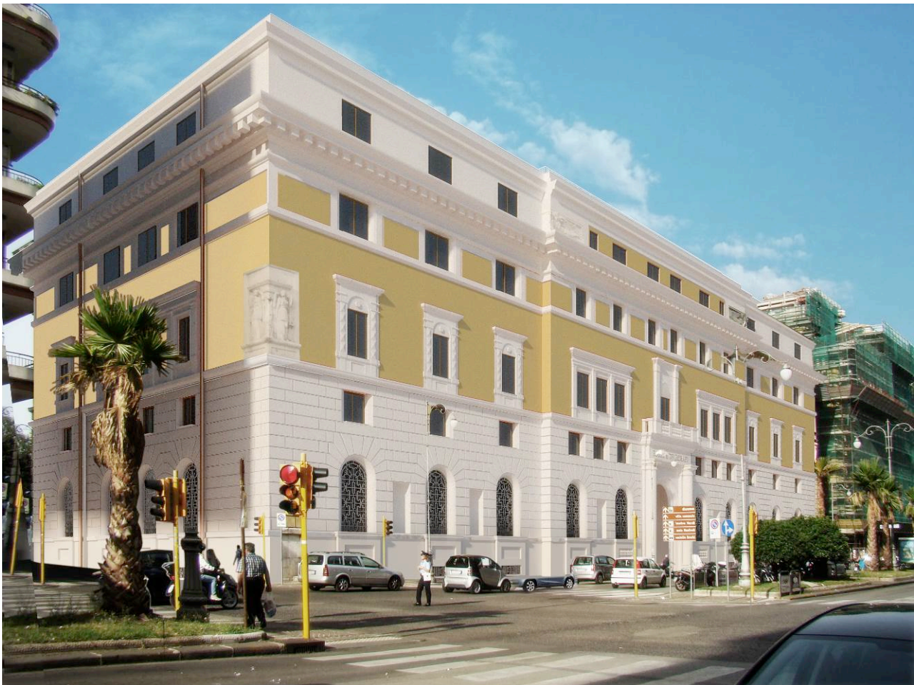
Fig. 1 – Fronte edificio su Corso Garibaldi
